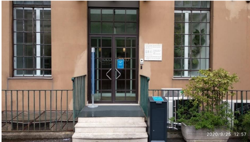
Vista dal cortile
